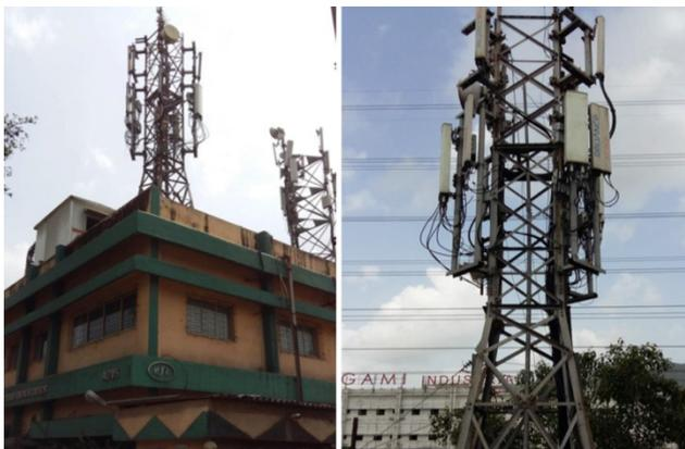
Figure 1. Mise à niveau d'un pylône avec FTTA
