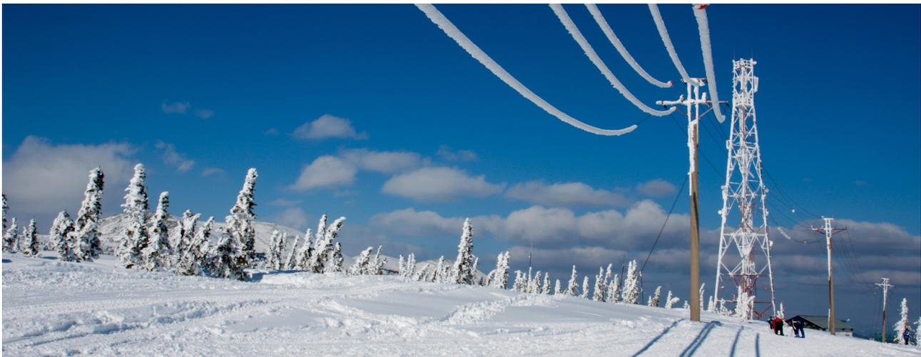
OPGW-Kabel sind Umwelteinflüssen, wie Blitzschlag, Eisbildung, Wind, Mastbruch und Kabelkorrosion, ausgesetzt. Die Glasfasern in diesen Kabeln werden als verteilte Sensoren genutzt, um die Lebensdauer des Stromverteilnetzes zu verlängern.
