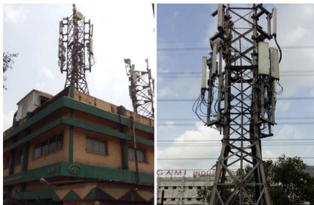
Рисунок 1. Современная базовая станция с решением Оптика до Антенны (FTTA)
