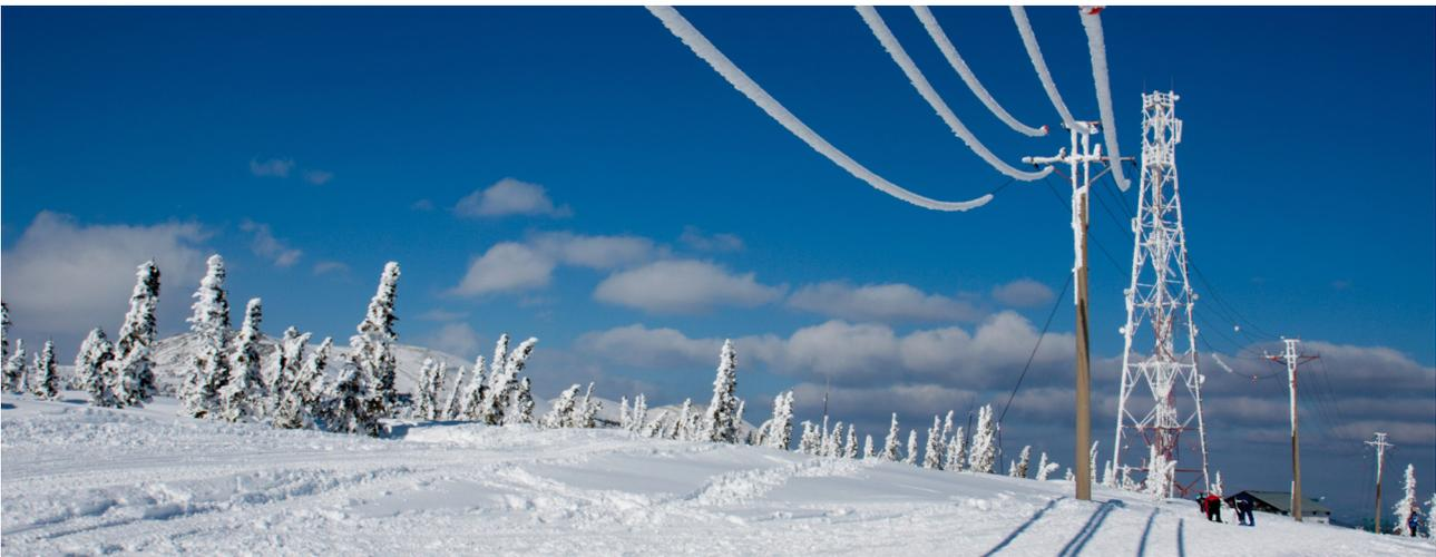
Les câbles OPGW subissent des contraintes environnementales dues à la foudre, au gel, au vent, à l'effondrement de pylônes, à la corrosion des câbles et à d'autres phénomènes. Les fibres au sein de ces câbles sont transformées en capteurs distribués afin d'accroître la longévité de l'infrastructure électrique.
