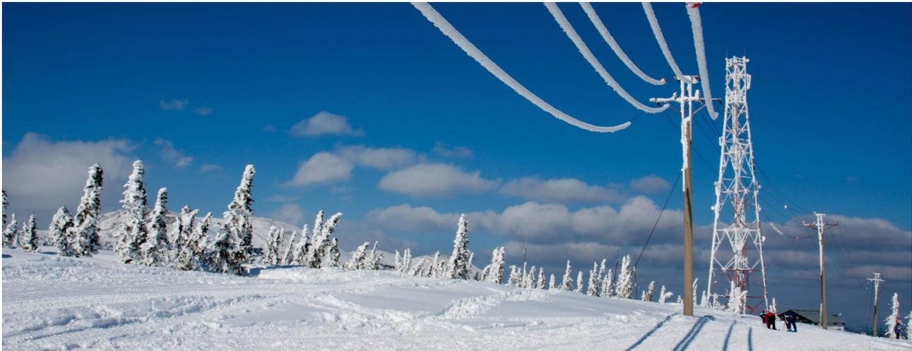
O OPGW está sujeito a estresse ambiental causado por raios, gelo, vento, colapso da torre, corrosão do cabo e muito mais. As fibras dentro desses cabos são transformadas em sensores distribuídos para aumentar a longevidade dos ativos.
